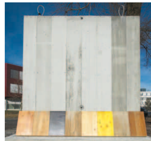
Fig. 14 Résultats d'essais avec divers types de peaux de coffrage.
