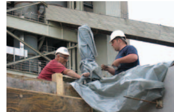
Fig. 12 Protection des fers en attente à l'aide d'une feuille plas- tique.
