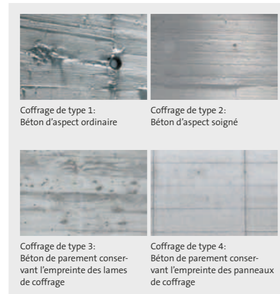
Fig. 17 Types de coffrages selon norme SIA 118/262 [1].
